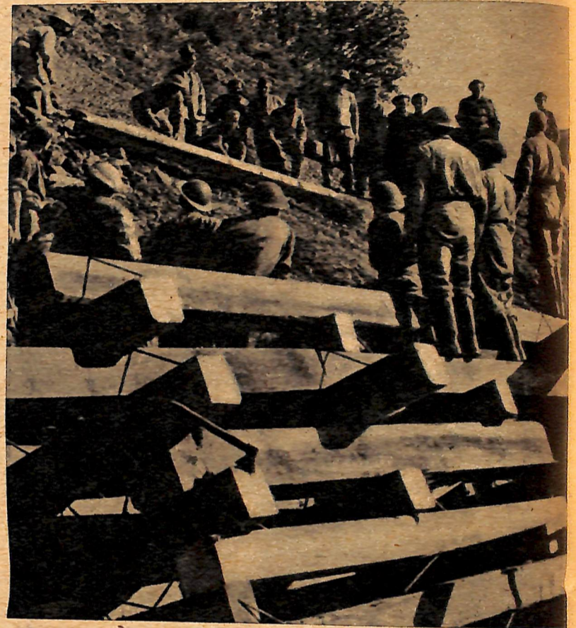
Droga nad rzeką Montone, budowana rękami polskich żołnierzy
