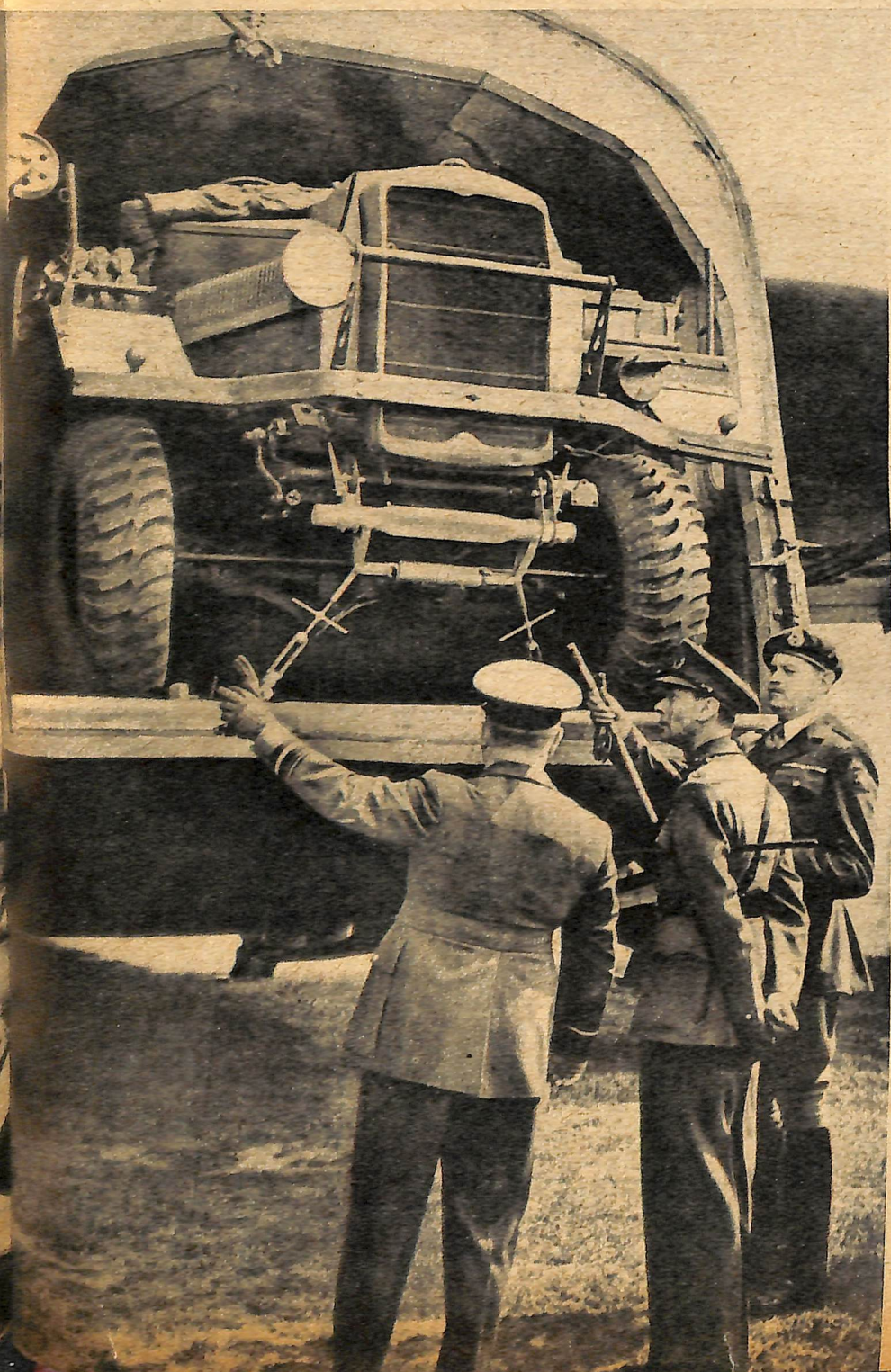
Czołg typu Tretowch (7 ton) — wraz ze specjalnym szybowcem służącym do jego transportu. Czołg i szybowiec stanowią całość
